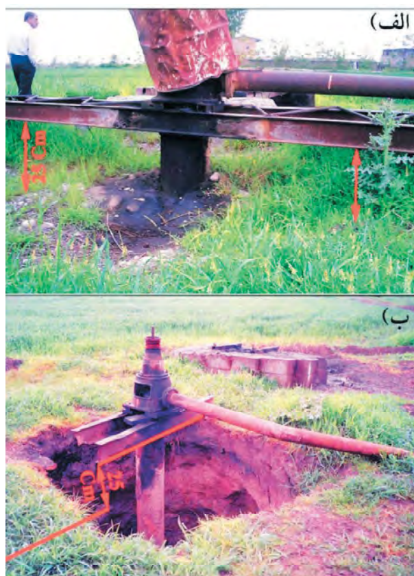
شکل ۹. الف و ب) پدیده لوله‌زایی ناشی از ۲۵ سانتی‌متر فرونشست دشت
