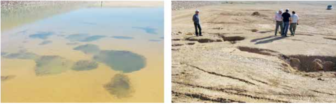
شکل ۳. نمایی از فروچاله‌های پدیدار شده در پتوی رسی مخزن سد بار
