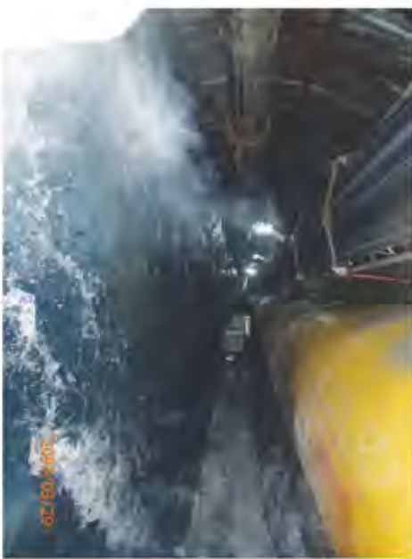
شکل ۵. مقطع تونل نوسود در گستره تاق‌بند زیمکان (الف- مهندسین مشاور ایمن‌سازان، ۱۳۹۴، مهندسین مشاور ایمن‌سازان، ۱۳۹۴؛ ب- مهندسین مشاور لا، ۱۳۸۳) و آب ورودی به تونل
